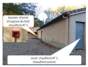
La chaudière 1 alimente le chauffage et le ballon d'eau chaude de la cuisine
